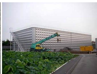
図4 配水池の全貌
