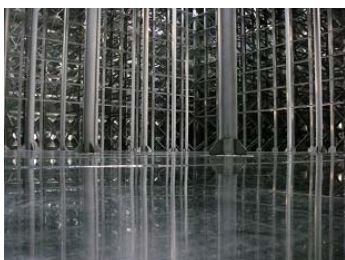
図2 配水池の内部状況(下部)
