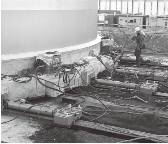
曳家工法により2日間で約27m移動させた
