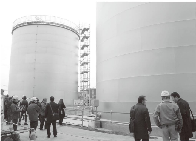
円筒形のステンレス製配水塔を2塔新設した
